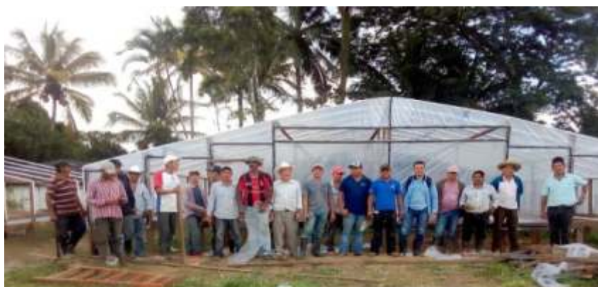
Construcción de secadora solar colectiva Villa Hermosa Trojes
